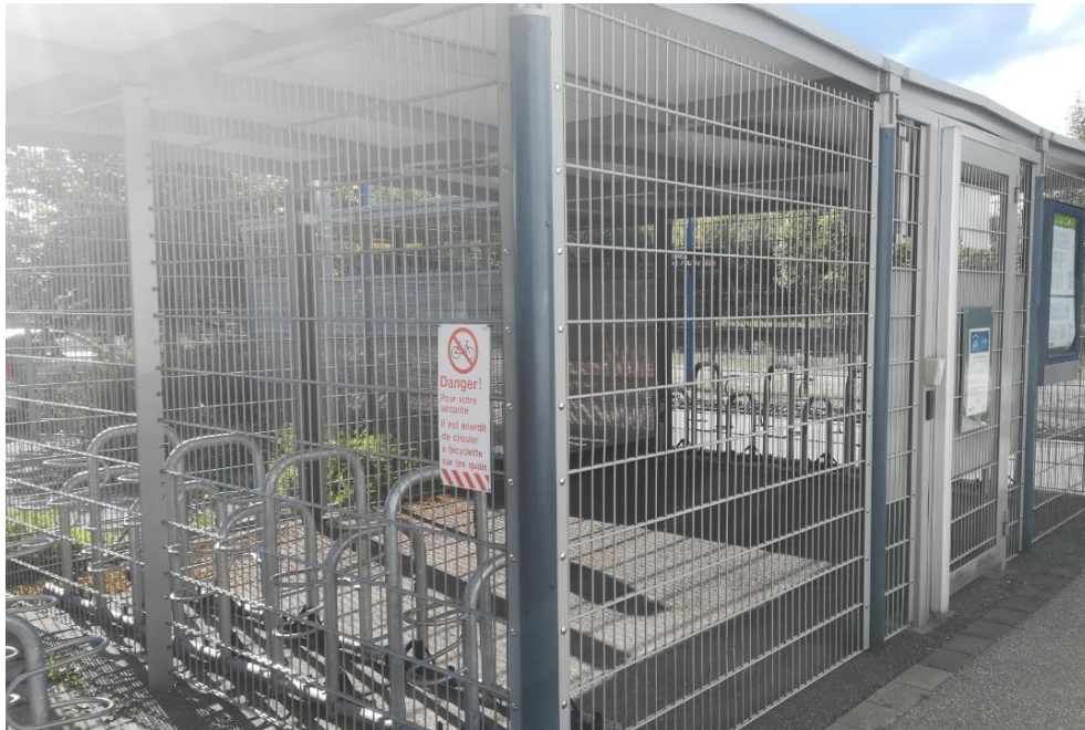
Figure 27: Photographie du garage à vélo fermé en gare de Saint-Blaise-la-Roche
