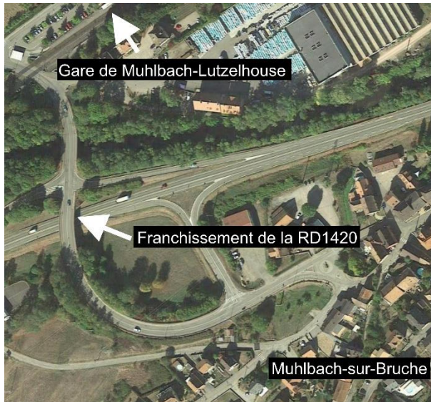
Figure 37: Vue aérienne du franchissement de la RD1420 entre Muhlbach-sur-Bruche et la gare
