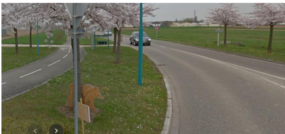
Figure 33 : Aménagement rue de la Gare entre Duttlenheim et sa gare
