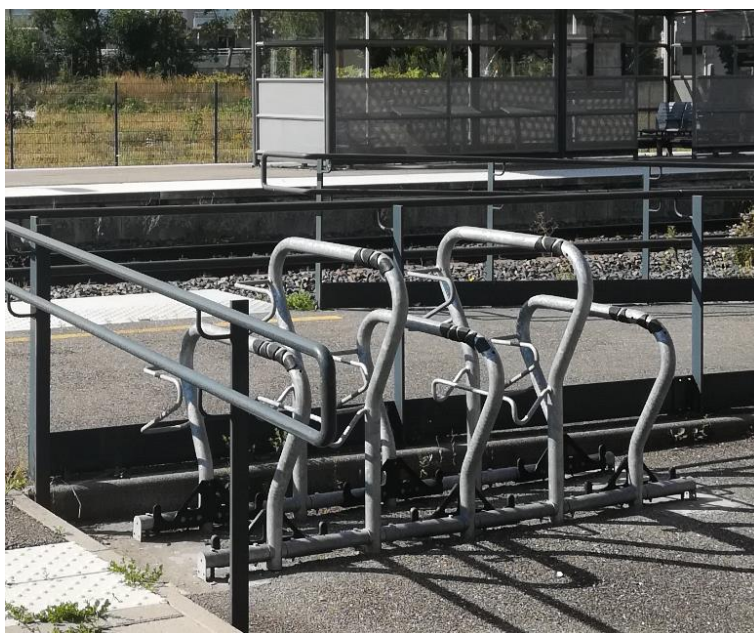
Figure 28: Photographie des anneaux d'accroche en gare de Schirmeck-La-Broche
