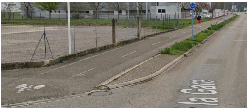
Figure 32 : Aménagement rue de la Gare entre Duppigheim et sa gare
