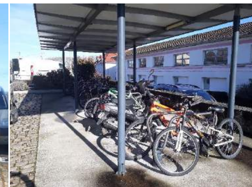
Des arceaux vélo sous l'abri moto
