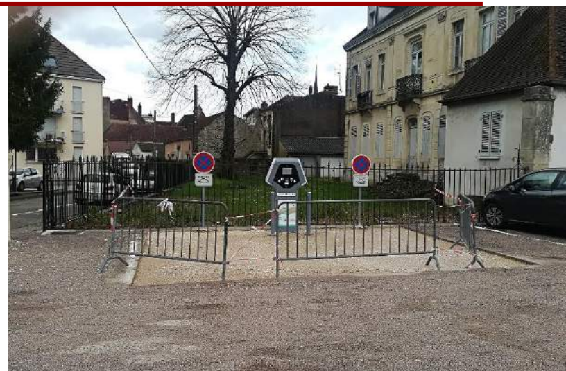
Bornes de recharge électrique en cours d'installation à Auxonne
