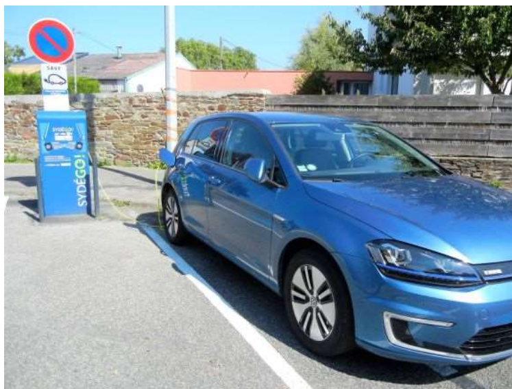
Borne de recharge électrique sur le parking Radevormwald à Châteaubriant
