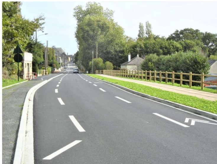
Chaussée à voie centrale banalisée aménagée à Derval en 2019
